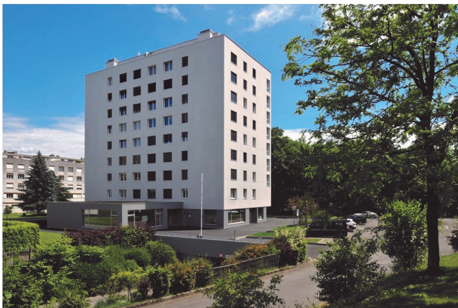
Immeubles chemin Ami-Argand 9-11 à Versoix – après travaux de rénovation Photo : Claudio Merlini
